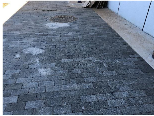
监测点2 透水铺装（施工后）
