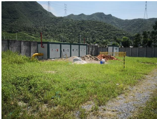
监测点 1 透水铺装（施工前）
