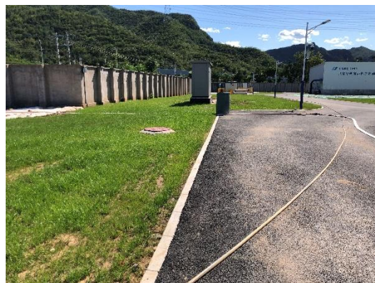
监测点 4 绿化（施工中）
