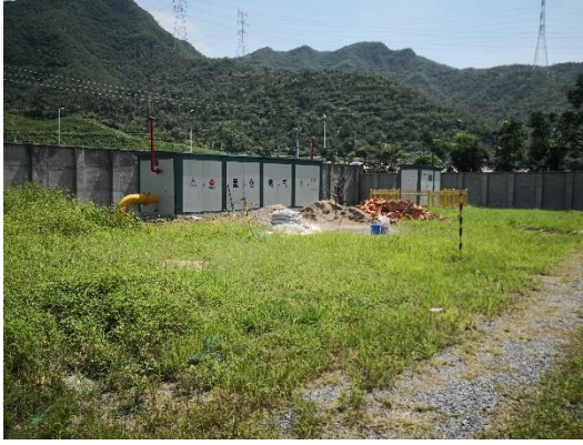
监测点 5 绿化（施工前）
