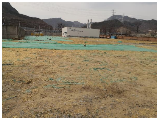
监测点 4 绿化（施工前）
