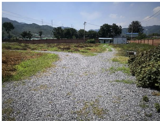
监测点 2 透水铺装（施工前）
