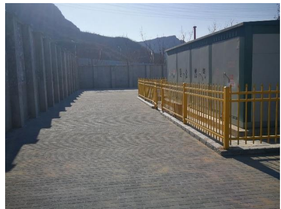
监测点 1 透水铺装（施工后）
