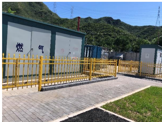
监测点 1 透水铺装（施工后）
