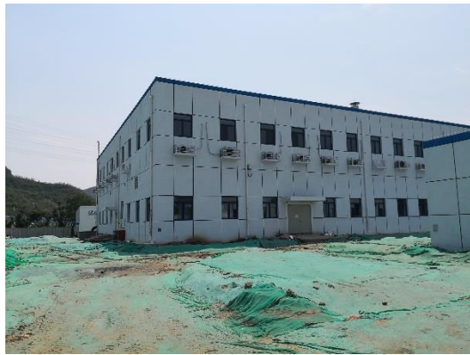
监测点3 下凹绿地（施工前）
