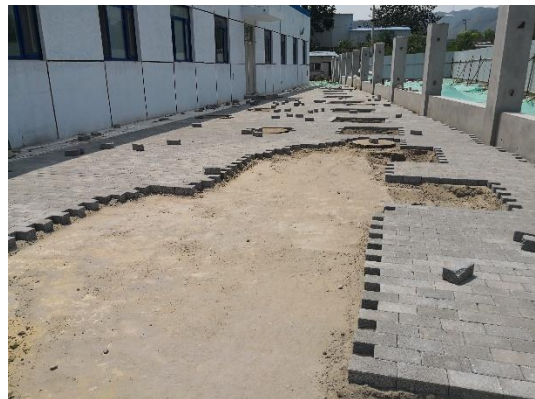
监测点 2 透水铺装（施工中）
