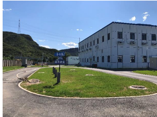
监测点3 下凹绿地（施工后）
