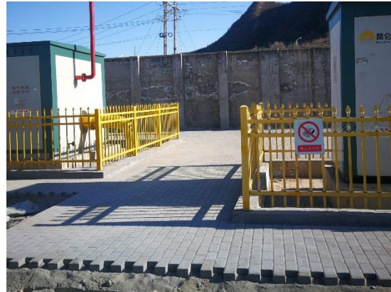
监测点 1 透水铺装（施工中）
