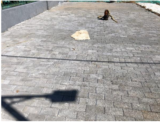
监测点2 透水铺装（施工后）
