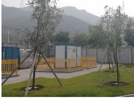
监测点 5 绿化（施工后）
