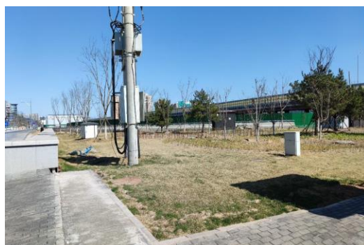
临时堆土区现状
