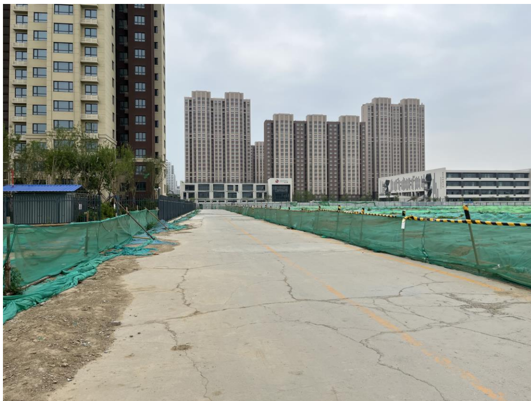
图 7.3.1 临时道路现场照片
