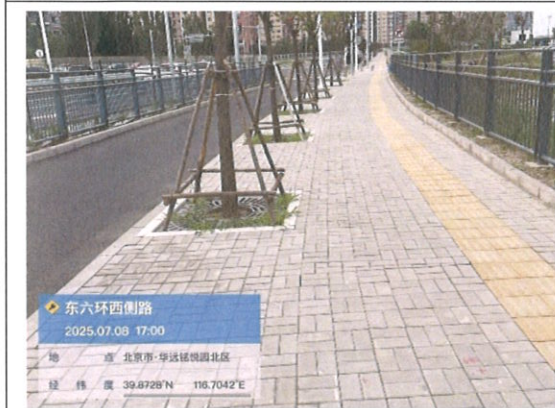
透水铺装和绿化
