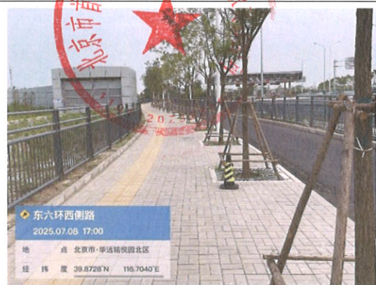
透水铺装和绿化
