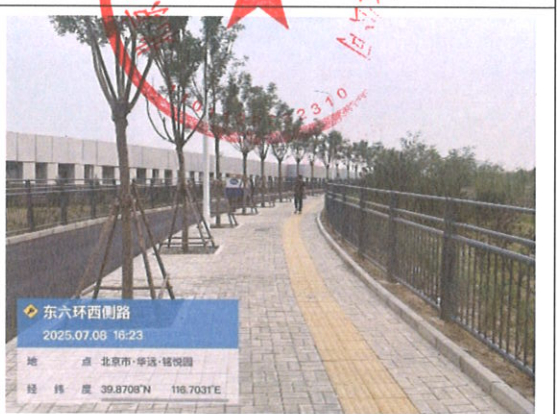
透水铺装和绿化
