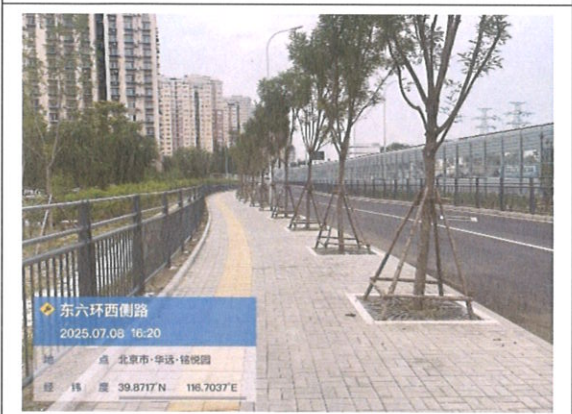
透水铺装和绿化
