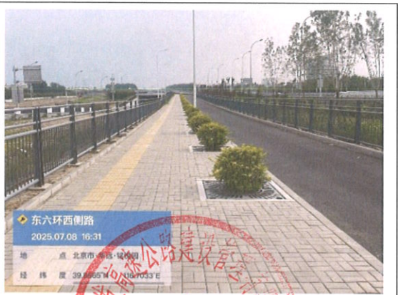
透水铺装和绿化
