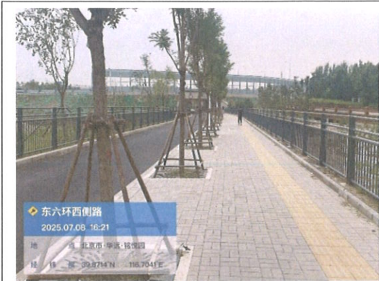
透水铺装和绿化
