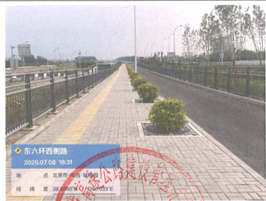
透水铺装和绿化
