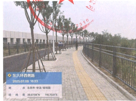
透水铺装和绿化
