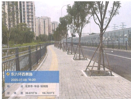
透水铺装和绿化
