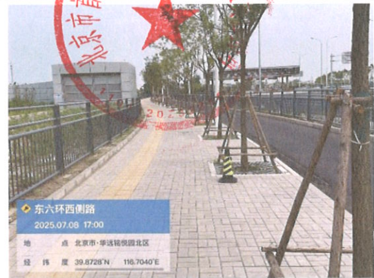
透水铺装和绿化
