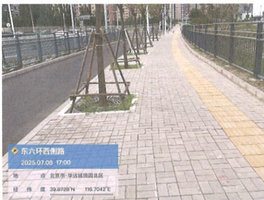
透水铺装和绿化
