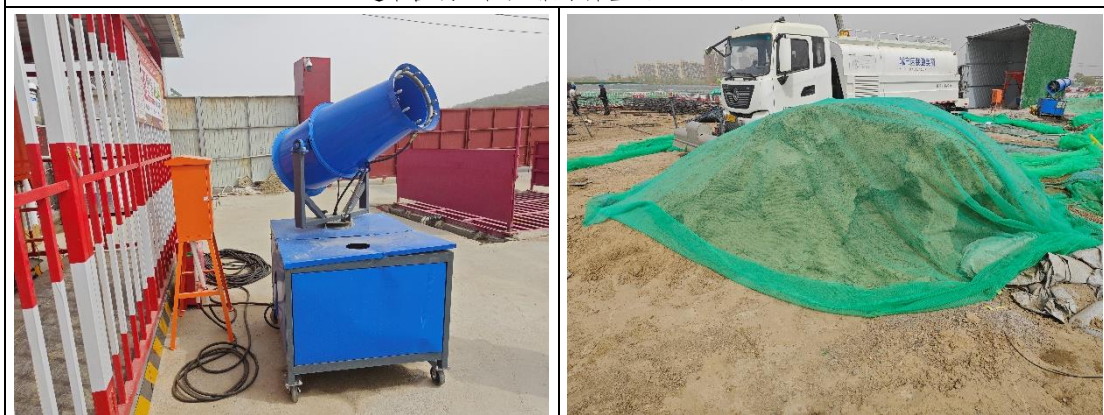
道路管线工程区-洒水降尘 (2023.04)
