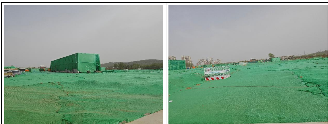
道路管线工程区-密目网苫盖 (2023.04)
