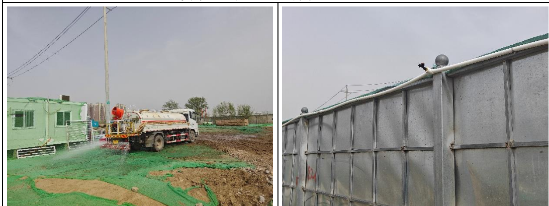
道路管线工程区-洒水降尘 (2023.04)
