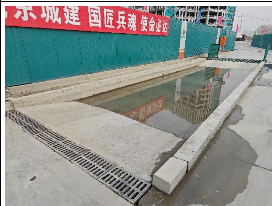
道路管线工程区-临时洗车池 (2024.03)
