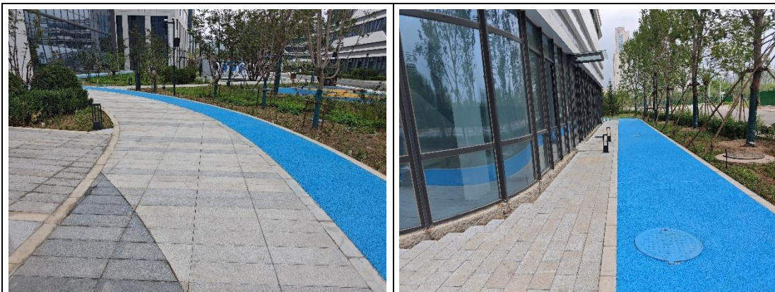
道路及管线工程防治区-透水砖铺装 (2025年7月)
