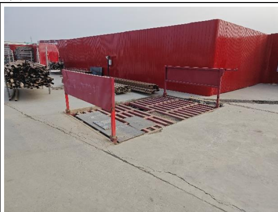
道路管线工程区-临时洗车池 (2023.12)
