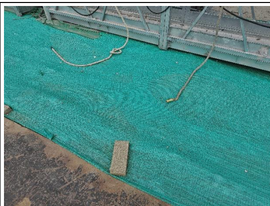
道路管线工程区-密目网苫盖 (2024.06)
