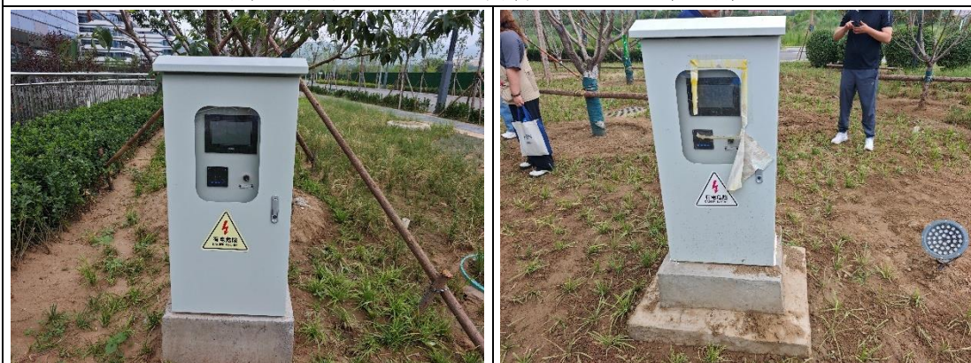
绿化工程防治区-雨水调蓄池 (2025年7月)
