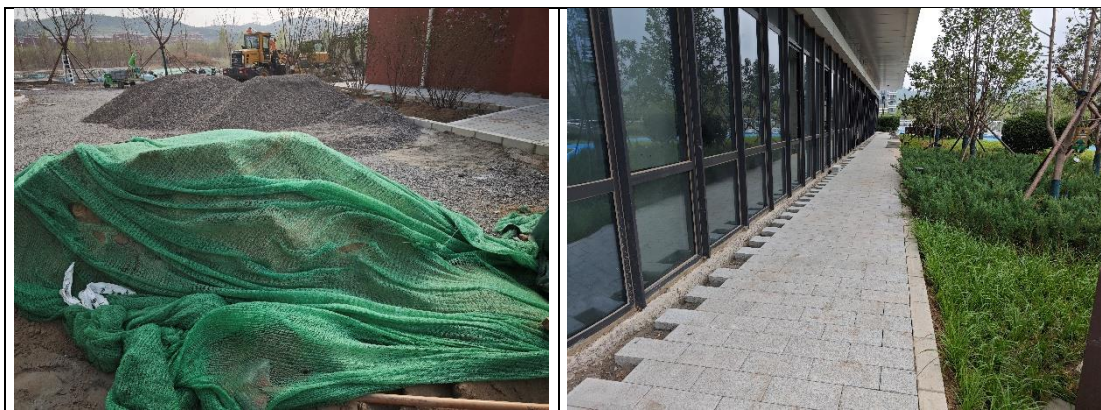
道路及管线工程防治区-透水砖铺装 (2025年6月)
