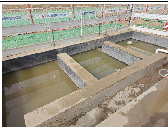
建筑物工程区-临时沉沙 (2023.07)
