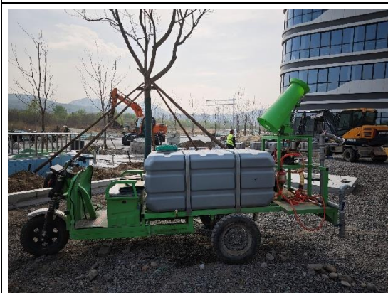
道路管线工程区-洒水降尘 (2025.03)
