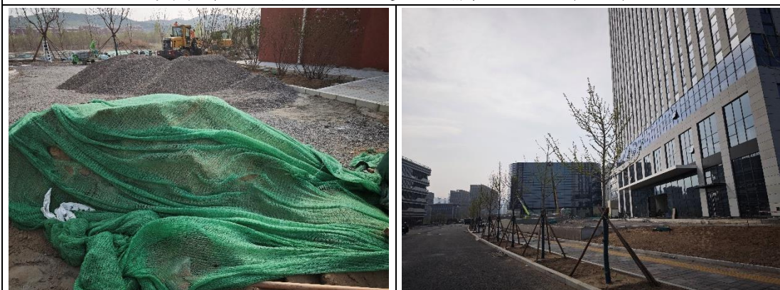
绿化工程防治区-下凹式绿化整地 (2025年4月)
