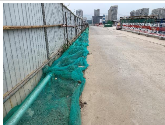
道路管线工程区-密目网苫盖 (2023.07)
