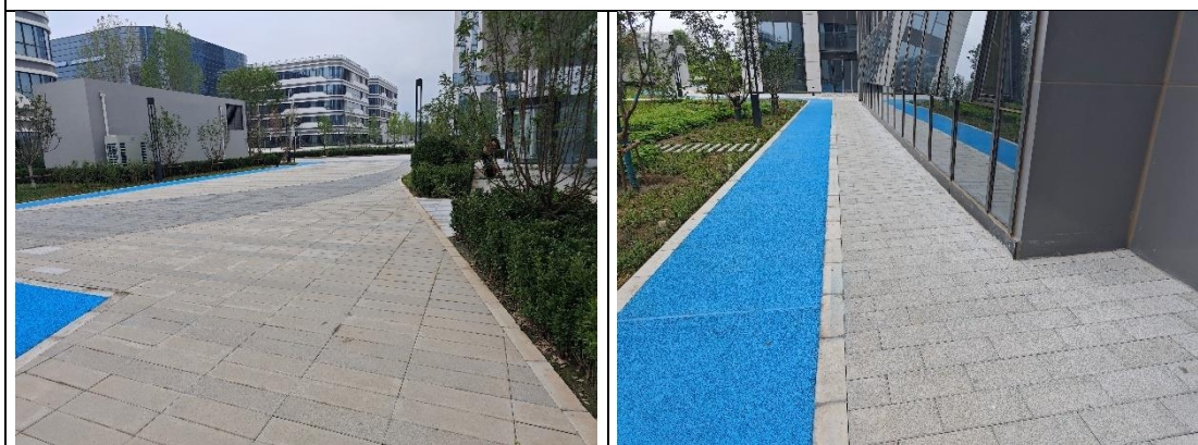
道路及管线工程防治区-透水砖铺装 (2025年7月)
